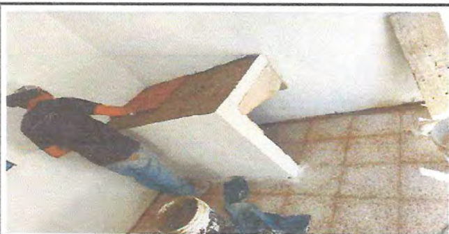
Foto 5: Elaboración de la hornilla e instalación de plancha comalera
