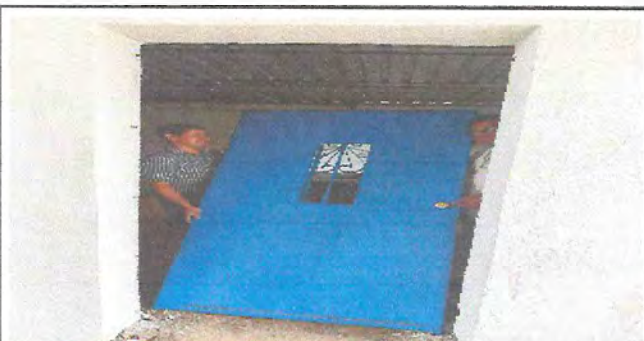
Foto 3: Sustitución de la puerta de la cocina
