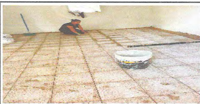
Foto 6: Sustitución de piso en la cocina, torta por piso granito
