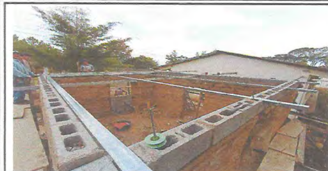
Foto 1: Colocación de block para ampliar la altura de las paredes
