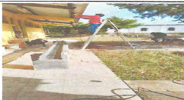
Foto 3: Colocando las bases para los canales
