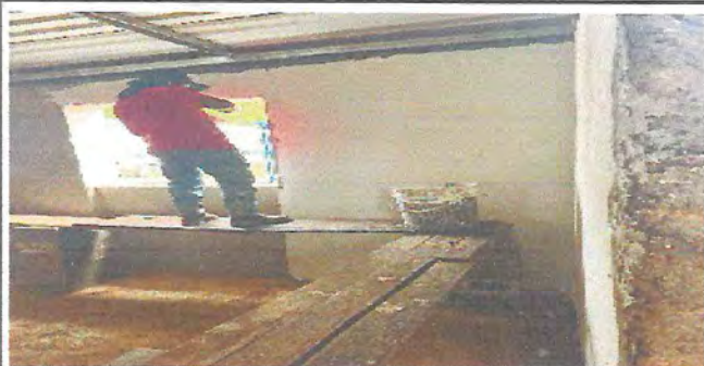
Foto1: Repello de las paredes por dentro
