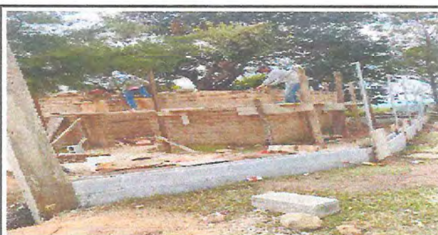
Foto 6: Preparando las paredes de la cocina para ampliar su nivel de altura
