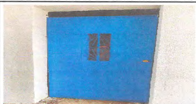
Foto 2: Sustitución de puerta de la cocina
