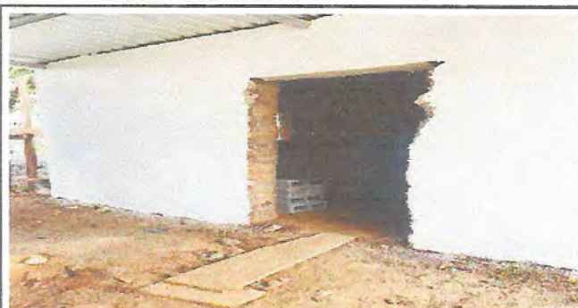
Foto 3: Sustitución de la puerta de la cocina
