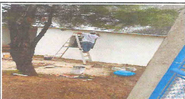
Foto 4: Repello de las paredes por fuera, segunda capa
