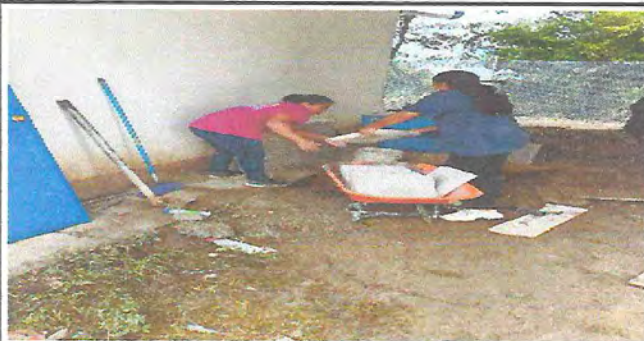
Foto1: Sustitución de pisos
